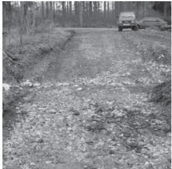
Abb. 3 und 4: Oben vor der Maßnahme, Fließgewässer unter dem Maschinenweg verdolt, Durchgängigkeit des Gewässers unterbrochen. Unten danach, mit Furt, Durchgängigkeit wieder hergestellt.
