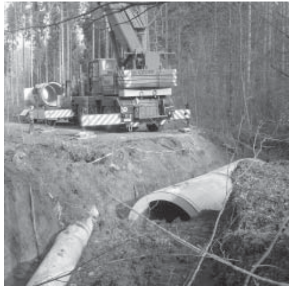
Abb. 5: Wiederherstellung der Durchgängigkeit mit Durchlass von 1,6 m Ø
