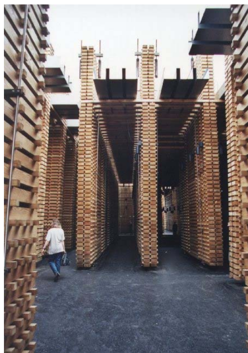
Abb. 10: Der Schweizer Pavillon auf der Expo 2000 in Hannover: Gebäude als künftige Rohstofflager
