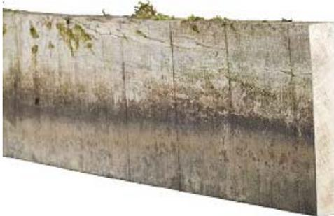
Abb.4:Uferbefestigung nach 10 Jahren im Einsatz
