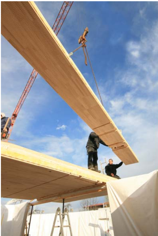
Abb. 2: Element nach obigem Schema bei der Montage.
