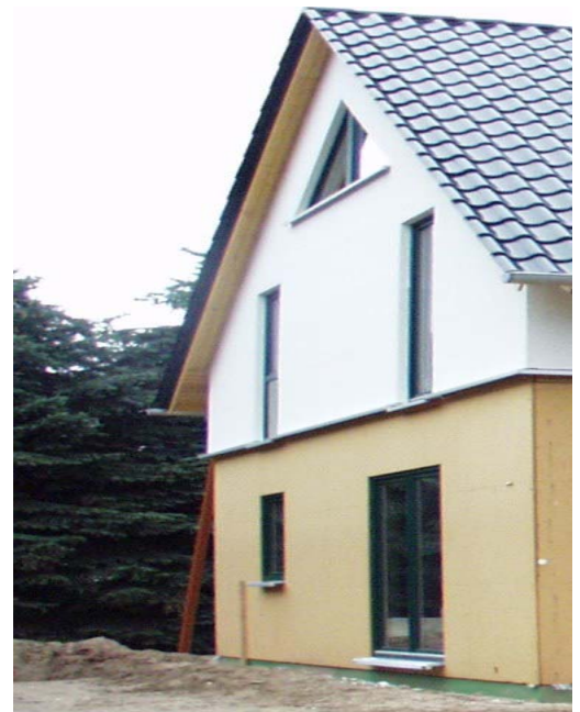
Abb. 5: Holzfaserdämmplatten als Außendämmung in der Wand; oben als WDVS (Typ WAP), unten hinter einer (noch nicht montierten) hinterlüfteten Fassade (Typ WAB).
