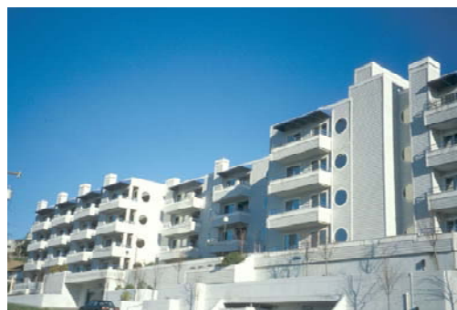
Abb. 5: Fünfgeschossiges Wohn- und Bürogebäude in Holzbauweise, Portland/USA (VHT)
