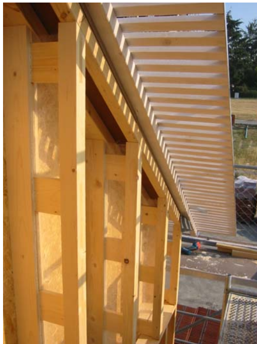
Abb. 3: Dämmständer mit Ortgang
