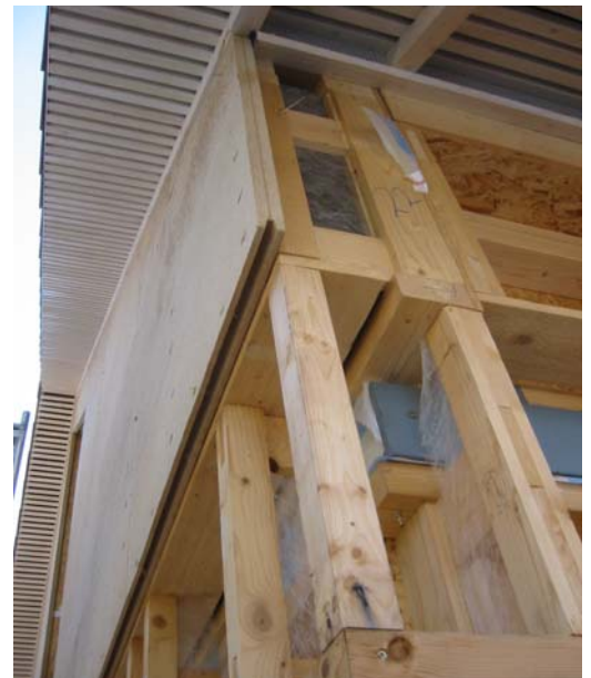
Abb. 2: Dämmständer Wandaufbau
