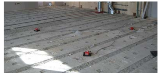
Abb. 5: Foto Messaufnehmer auf der Rohdecke
