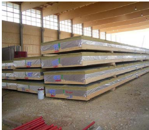
Abb. 2: Dachelemente einer Industriehalle bei der Zwischenlagerung und Montage (Bild: Schwörer Haus)
