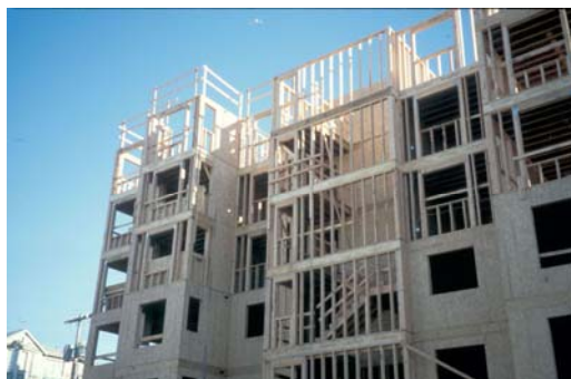
Abb. 6: Mehrgeschossiger Holzbau in Vancouver/Kanada (VHT)
