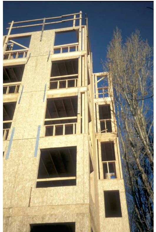
Abb. 1: Mehrgeschossiger Holzbau in Vancouver/Kanada (VHT)
