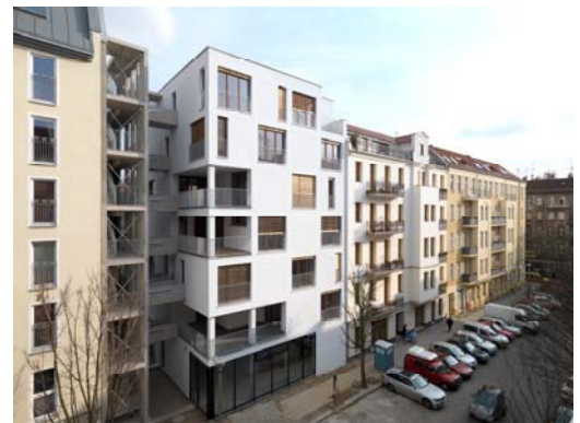
Abb. 3: Siebengeschossiges Gebäude in Holzbauweise in Berlin.
