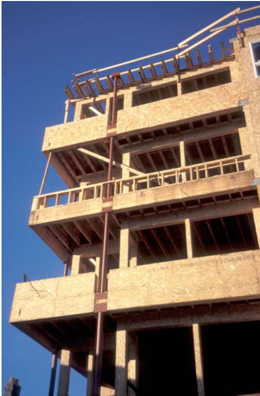
Abb. 8: Fünfgeschossige Wohnanlage in Holzbauweise, Lahti/ Finnland (VHT)
