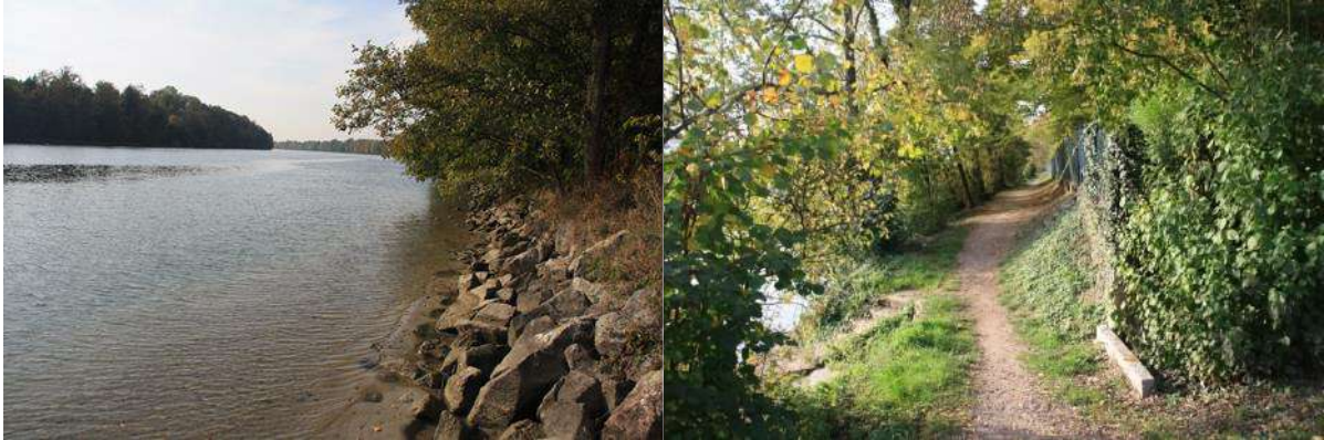
Abbildung 40: Links: Uferverbauung zwischen Obersäckingen und Murg. Rechts: Fischereipfad und gezäunte Kleingartenanlage entlang des Rheinufers.
