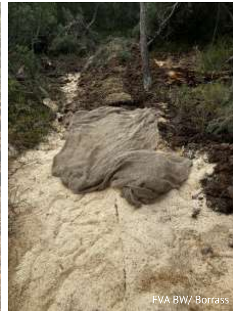
Bedecken der Sperre mit Textil, Torf
