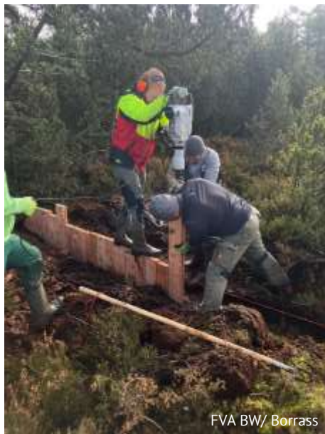
Einbringen der Bohlenwand
