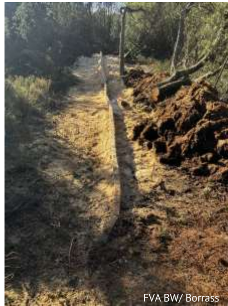
Verfüllung mit Sägemehl
